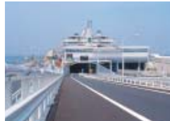
「S528」の施工事例 海ほたる
