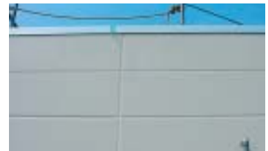
耐候性ウレタン系シーリング材施工
