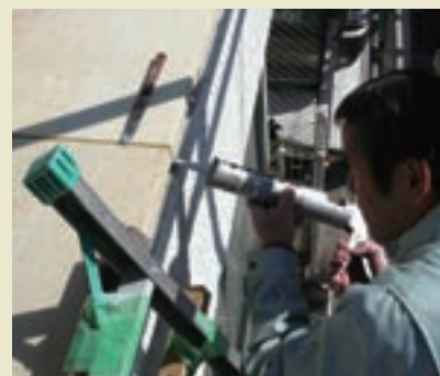
カートリッジガンに POSシール(333ml)を 装着して施工中
