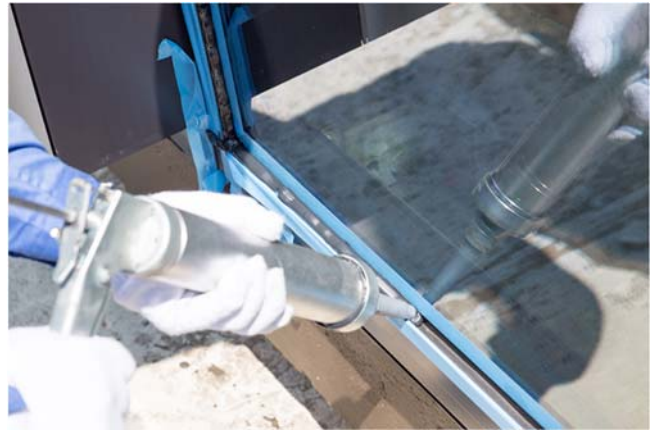
※セメダイン『EXCEL II』施工例
