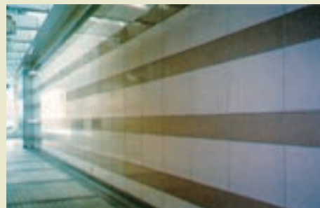
大型タイルの接着施工実績
